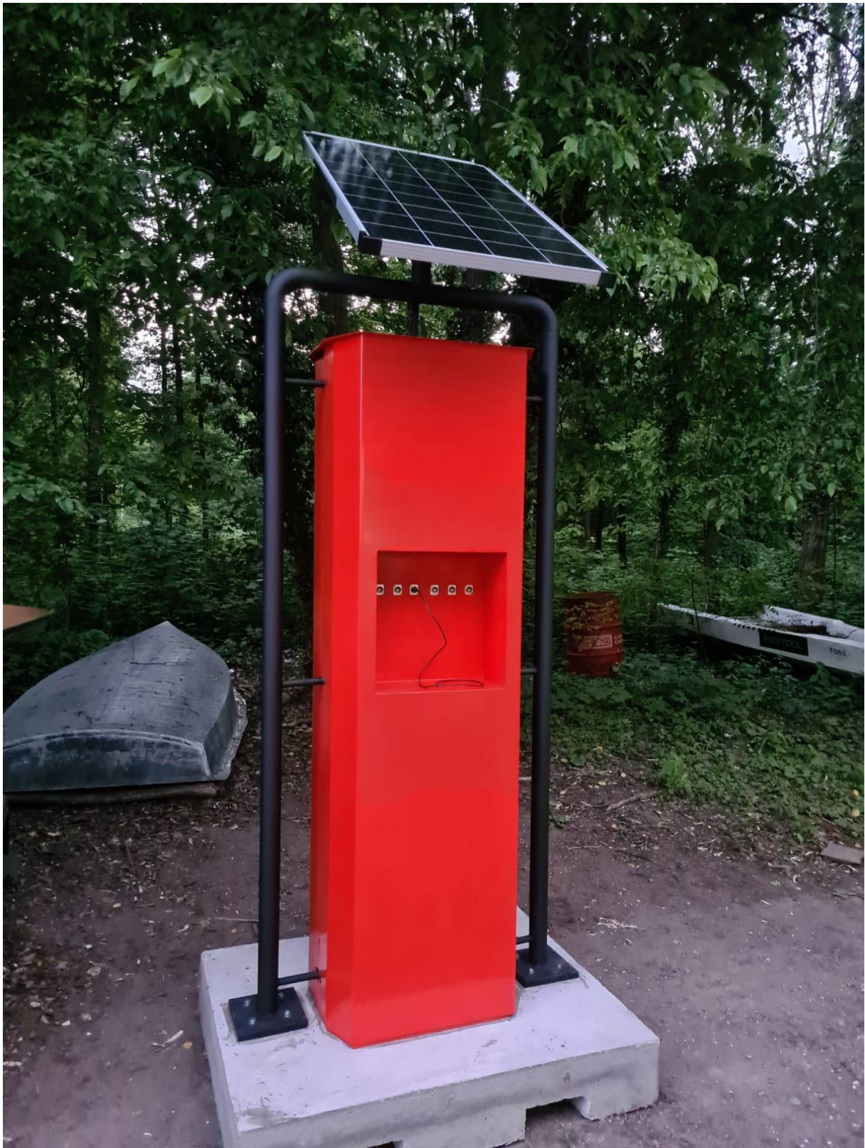
Abbildung 19: Solarladestation HKA
