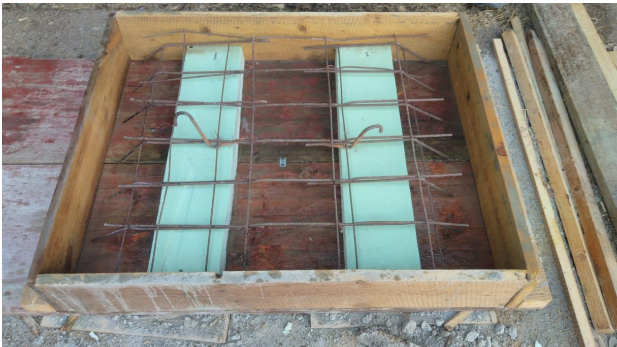
Abbildung 1: Schalung für Betonpalette mit Zusätzen
