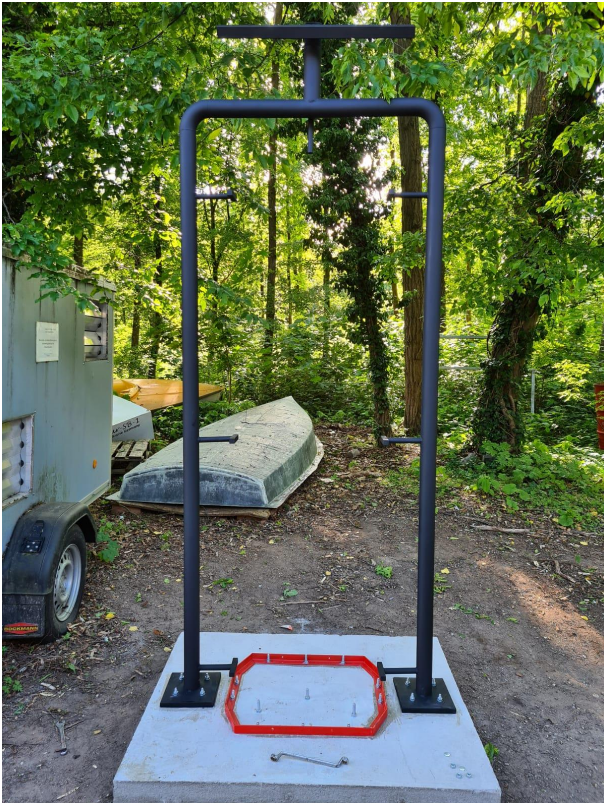
Abbildung 12: Bogen montiert auf Betonpalette
