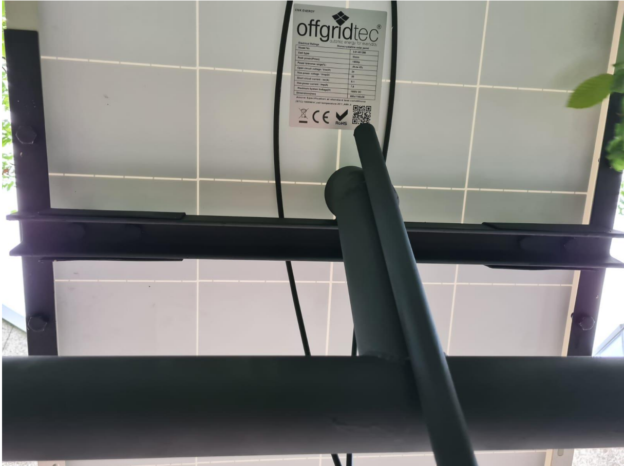
Abbildung 16: Befestigung der Solarplatte
