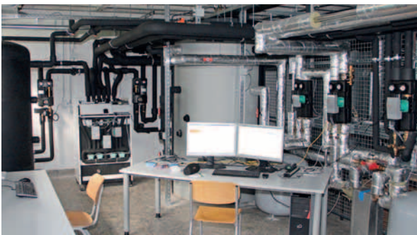
Abb. 1: Laboranlage mit Adsorptionskältemaschine, thermischen Speichern und Arbeitsplätzen (Foto: Adrian Bürger)
