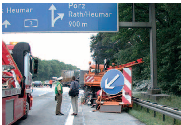
Abb. 1: Unfall in einer AkD (Foto: Landesbetrieb Straßenbau NRW)
