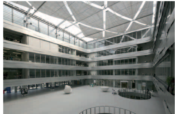
Abb. 3: überdachtes Atrium nach der Sanierung (Foto: Hochschule Karlsruhe)
