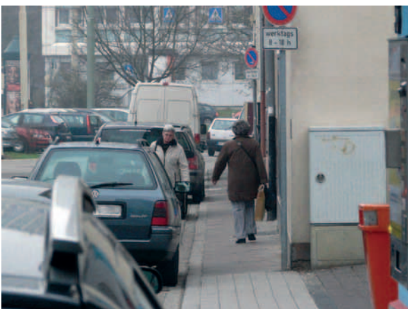
Abb. 1: Gehwege sind zu schmal für den Begegnungsfall zweier Fußgänger oder das Nebeneinanderlaufen und Unterhalten („kleine“ Rheinstraße, Karlsruhe, Foto: Jan Riel)
