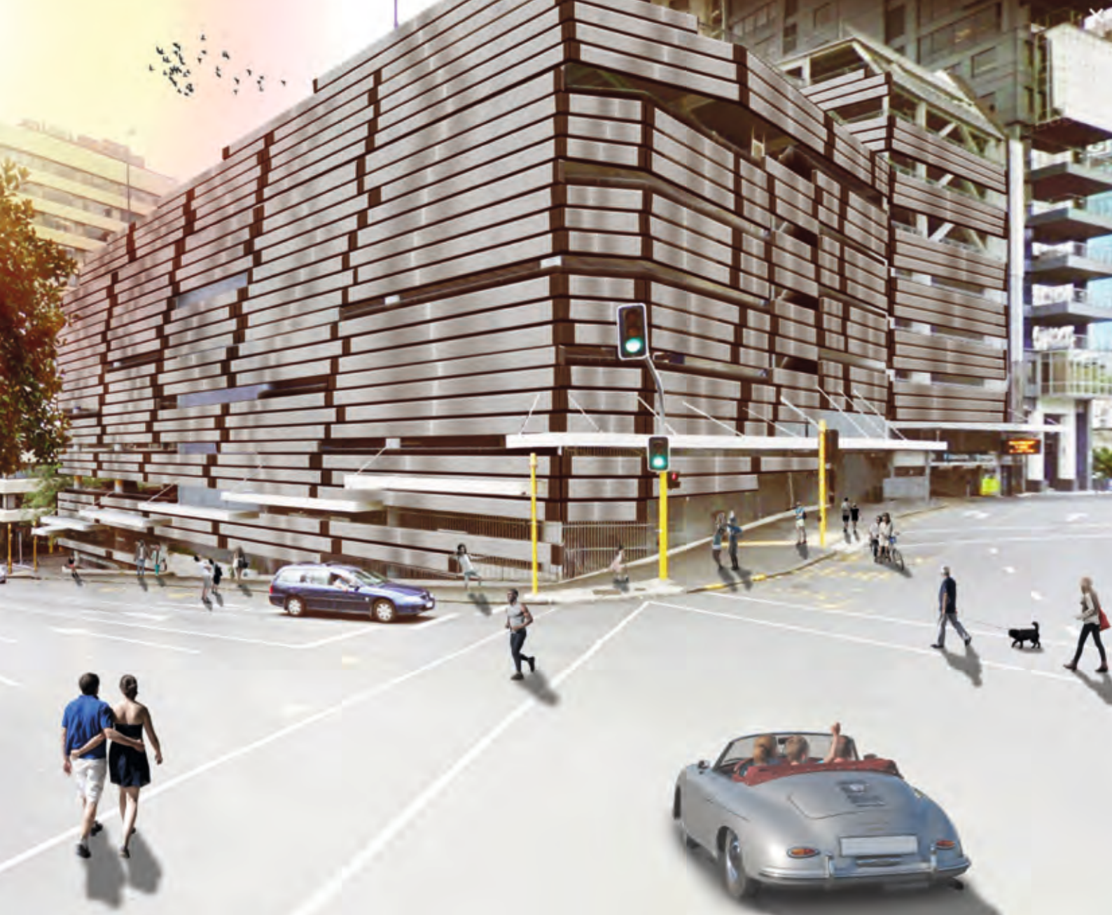
Abb. 1: Die Fassaden von Parkhäusern lassen sich mit Verdunstungselementen nachrüsten (Grafik: Lena Knoblauch und Jonas Haug)
